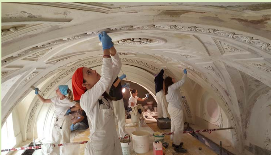
Gli studenti al lavoro nel cantiere-scuola presso la Chiesa del Carmine di Spirano
