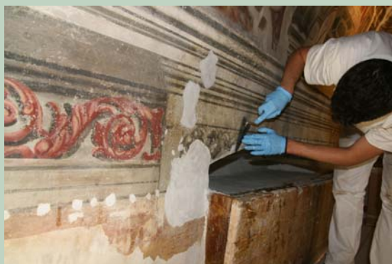
Restauro della Sala Bianca di Palazzo Pesenti: fasi di consolidamento strutturale e di restauro delle stuccature
