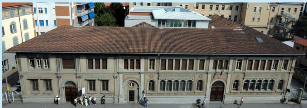
La scuola dall'alto dopo la realizzazione del progetto di ampliamento
